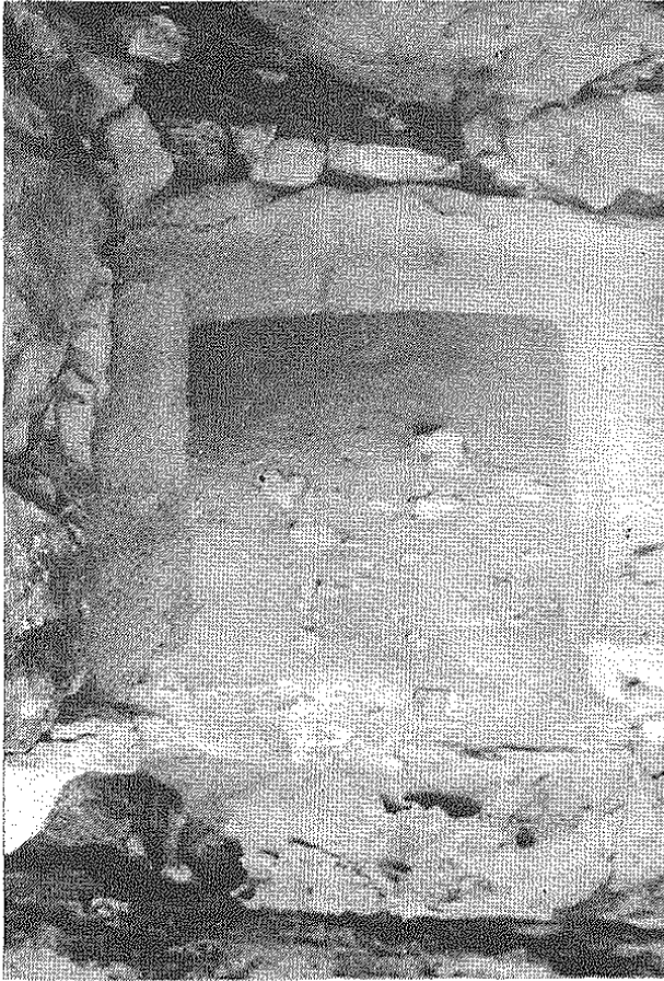
Losa perforada desde el exterior. Obsérvese el rebaje en bisel.
