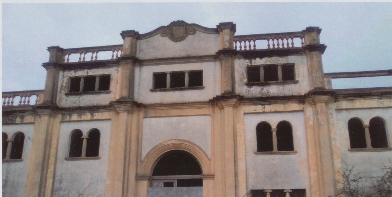
Façana principal de l'antic Celler Cooperatiu de Felanitx
