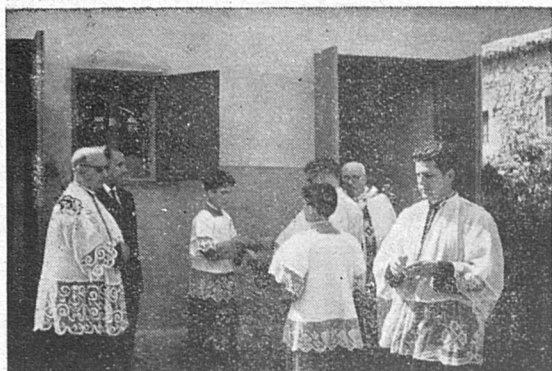
Bendición del Transformador
