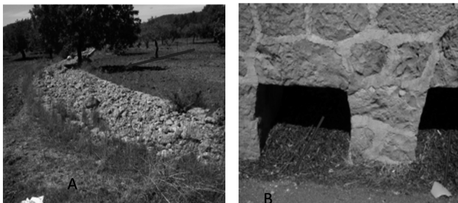
Figura 4: marjades a Es Cabàs (A), i clavegeres a la carretera de Bunyola (B).
