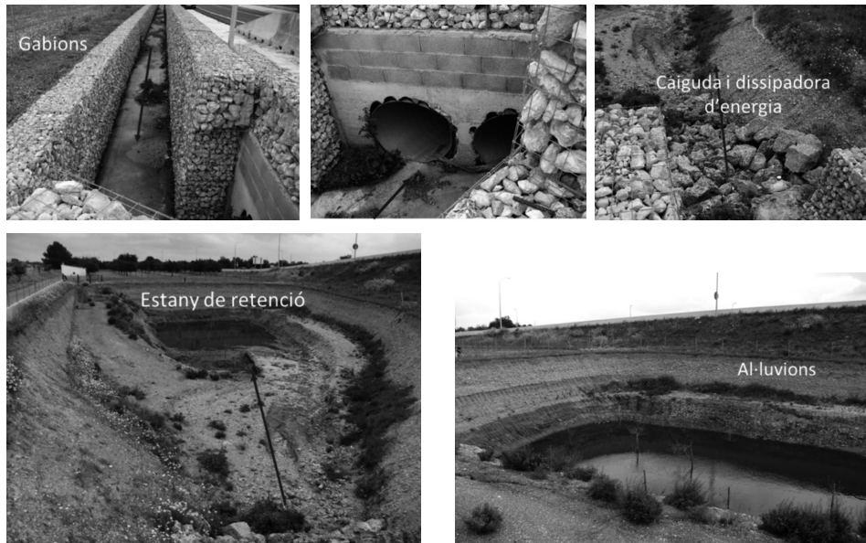
Figura 6: intervenció en el nou accés a l'autopista (Ma-13) des de la carretera Ma-13a.
