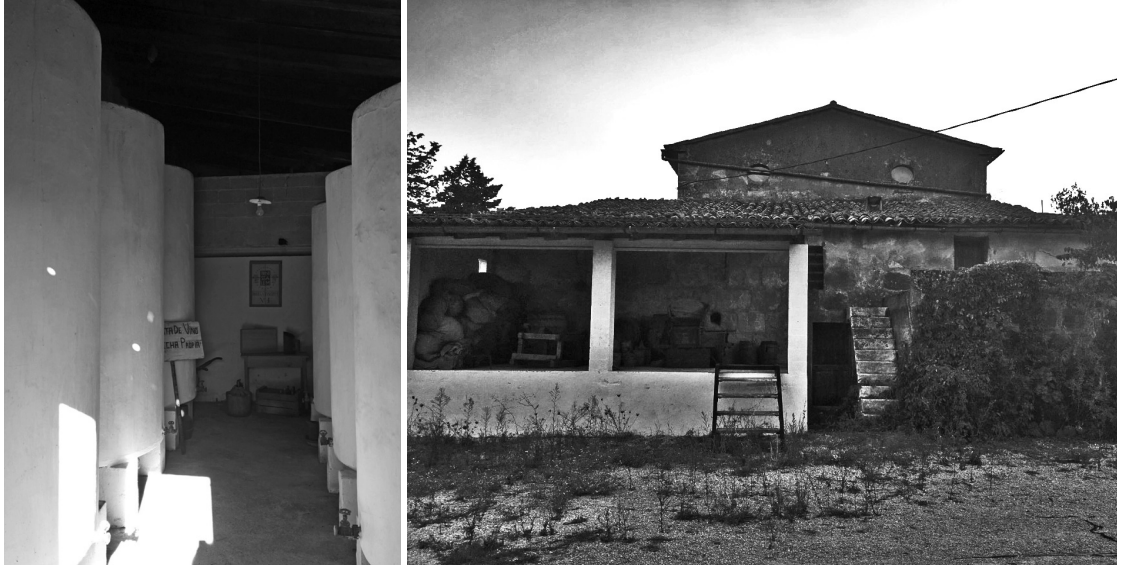
Figura 6a. A la dreta: Interior de la celler de Can Cerdó, s'aprecien els 6 dipòsits cilíndrics de ciment armat de 2.000 litres. A l'esquerra: porxo on hi ha els dos cups semi enterrats.
