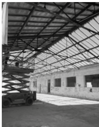
Treballs de demolició de la fàbrica de Yanko. Estiu de 2022
