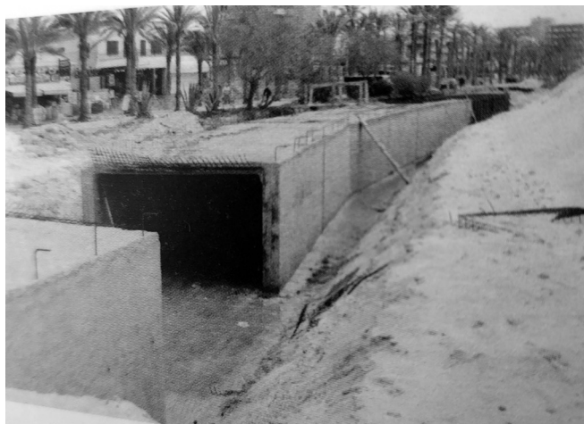
Construcció del canal ( caz ) (4).
