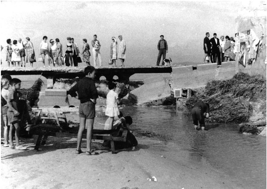
Estat en què quedà el pont del torrent construït per al pas dels vehicles.
