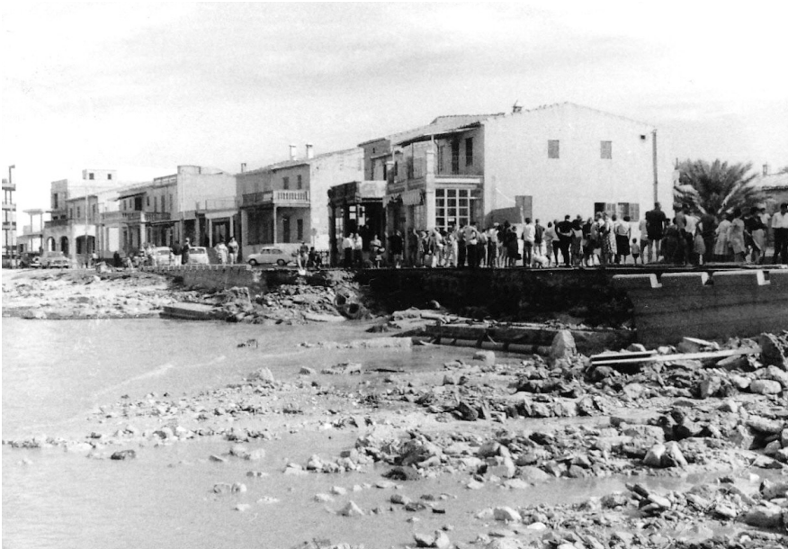
Imatge del pont derruït.
