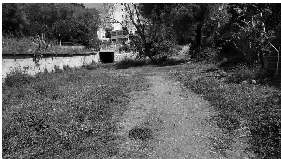
Embotellament del torrent que es produeix per la construcció de les piscines (9).
