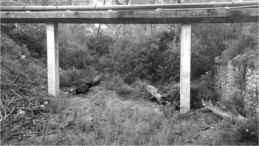
Nou pont de formigó per al pas d'aigües residuals (17).
