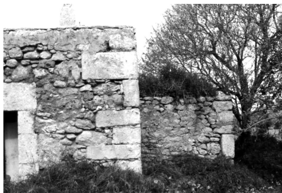
Detall de la façana.
