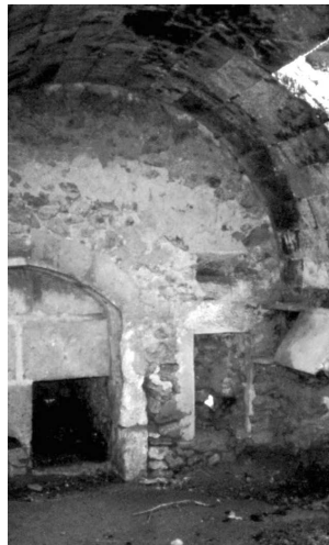
Interior de la caseta.
