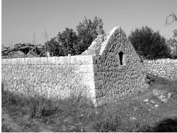
Part posterior de la barraca amb el finestró adovellat.
