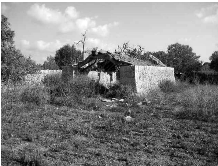
Imatge on es pot comprovar el mal estat de conservació de la barraca.
