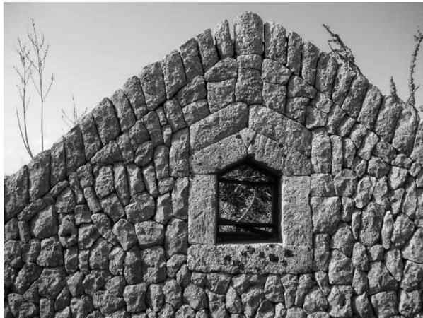
Finestra i encadenat posterior de la barraca.
