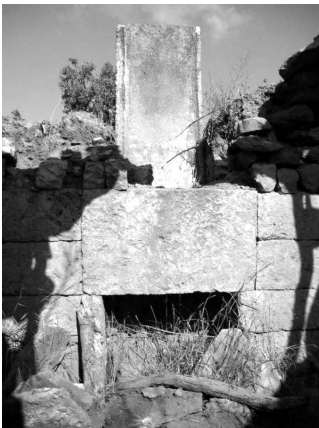
Finestra i encadenat posterior de la barraca.
