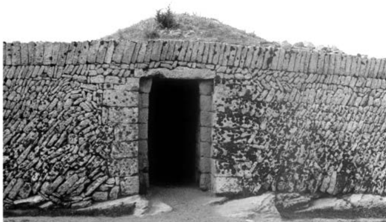
Portal de la barraca a la façana principal, a l'interior del corral.
