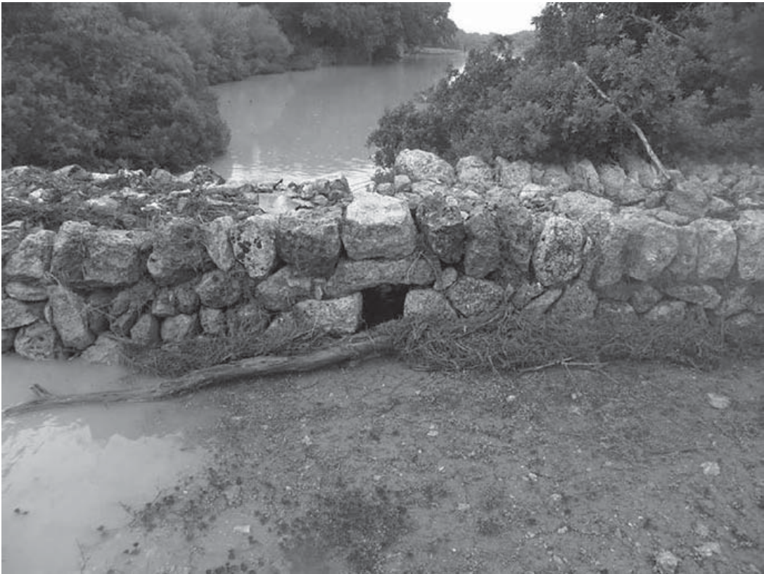
L'episodi remet, les clavegueres inferiors continuen drenant les aigües i el parat continua intacte (29-09-2009).
