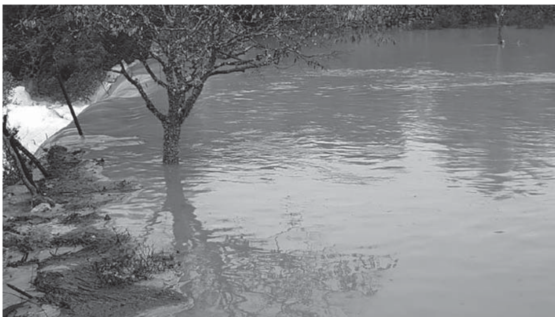
El mateix parat a la plena de la torrentada. Les clavegueres totalment obstruïdes i en ple procés de regulació de l'escorrentia. S'observa un augment de les turbulències aigües avall, que ocasionen danys a la base de l'estructura (19-12-2016).
