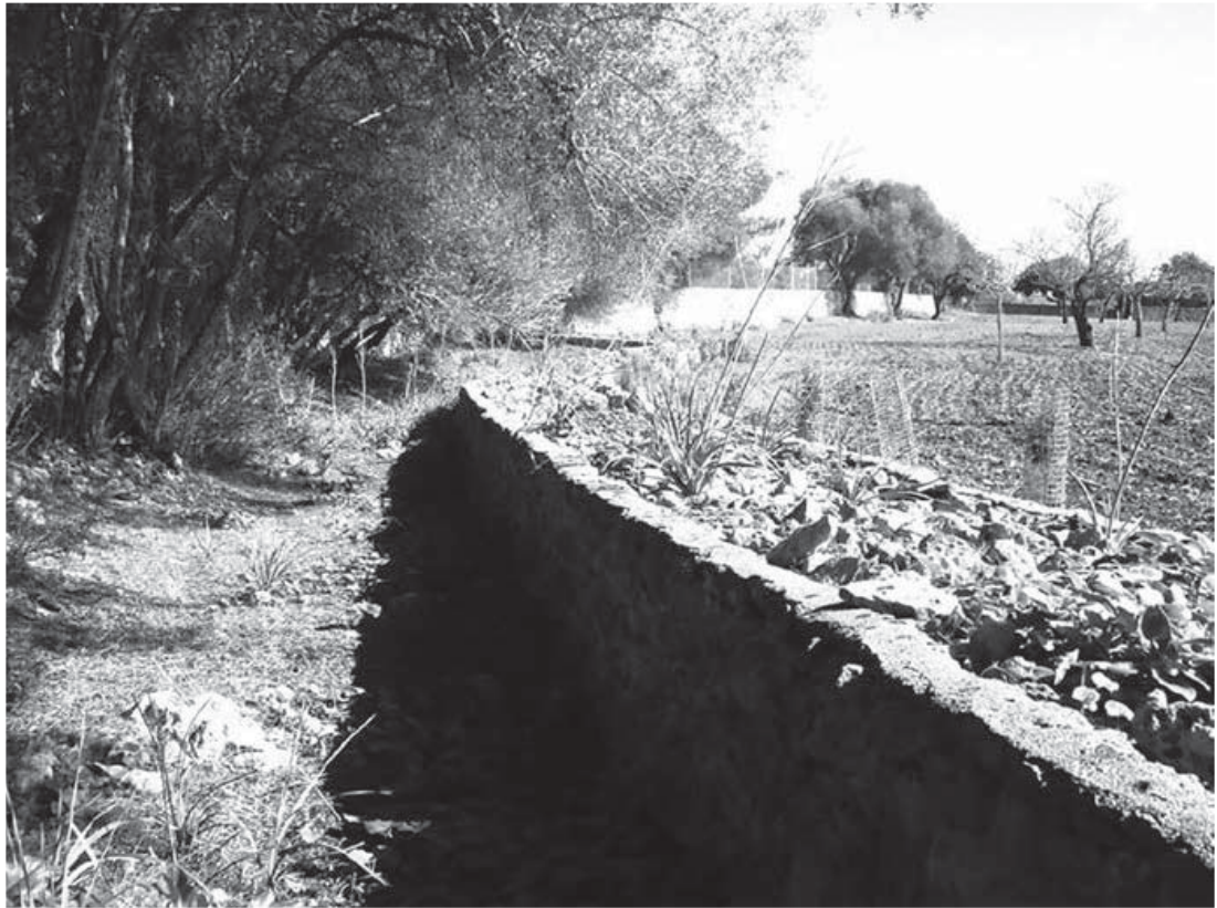
Parat de desviació de les aigües cap a l'avenc de ses Comes.
