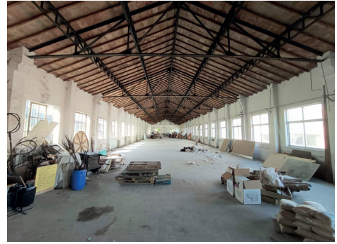
Figura 10. Nau principal del recinte industrial.
