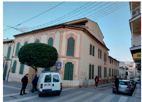
Figura 12. Cantonada de la façana principal.
