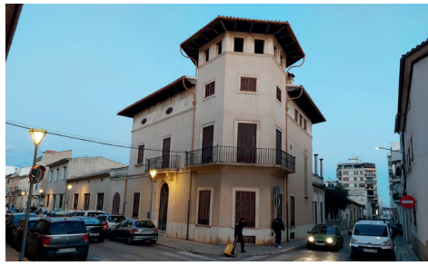
Figura 20. Cantonada de la façana principal.
