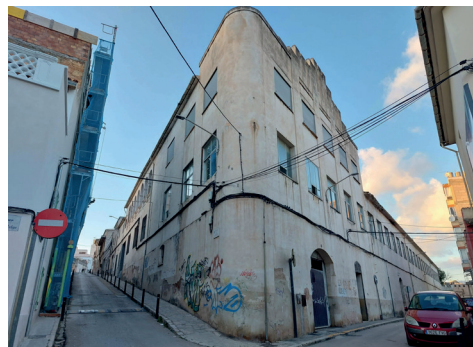
Figura 8. Cantonada de façanes a carrer.
