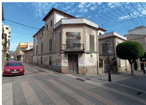
Figura 16. Cantonada de la façana principal.
