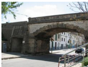
Figura 18. Pont del tren
