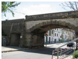
Figura 18. Pont del tren
