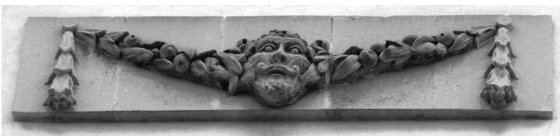
Figura 9. Detall de la façana del Teatre Principal
