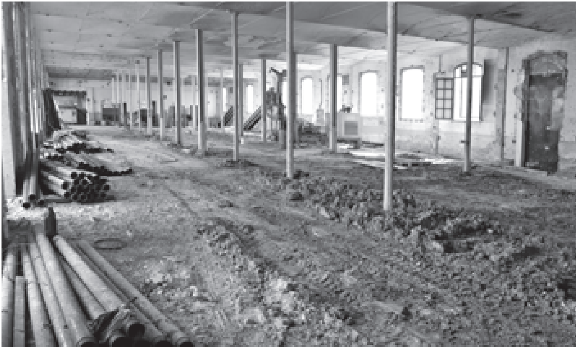
Figura 5. La nau sud (planta baixa), en el moment en què s'instal·laven els micropilots
