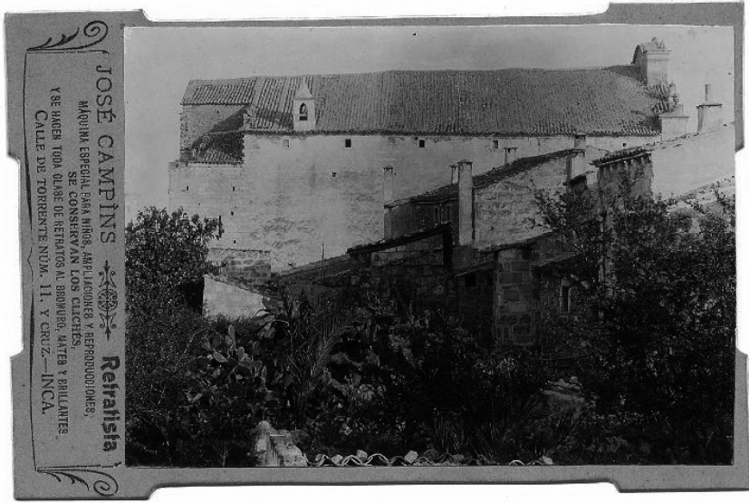
Fig. 4. Estat del campanar de St. Francesc abans de la intervenció de Guillem Reynés (AGR)
