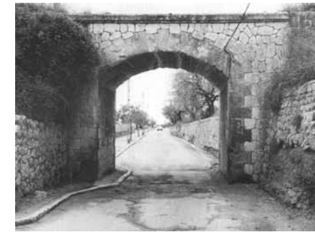
Figura 2. Puente del ferrocarril dirección cementerio
