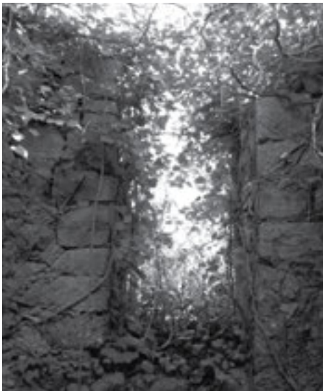
Portal alt de la segona habitació
