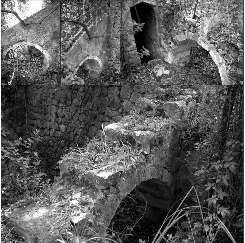
Diferents vistes dels contraforts de la sínia sobre la síquia del molí
