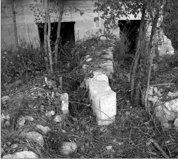
Síquia; a l'esquerra, cantonades de la fibla que permet desviar l'aigua al torrent; al fons, bifurcació de la síquia que es dirigeix als cups
