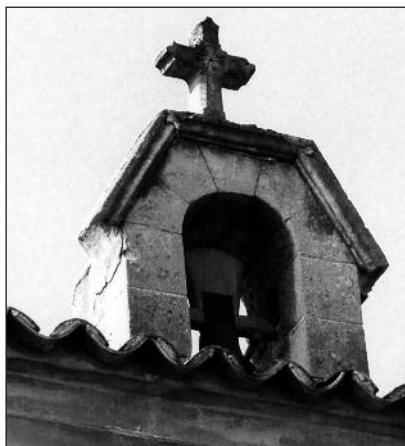
Espadanya i campana ubicada al coronament de la façana principal del convent.
