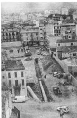
Figura 5.- Canalització del torrent de Cantabou al mateix lloc que la fig. 4. Font: setmanari Dijous. 1991
