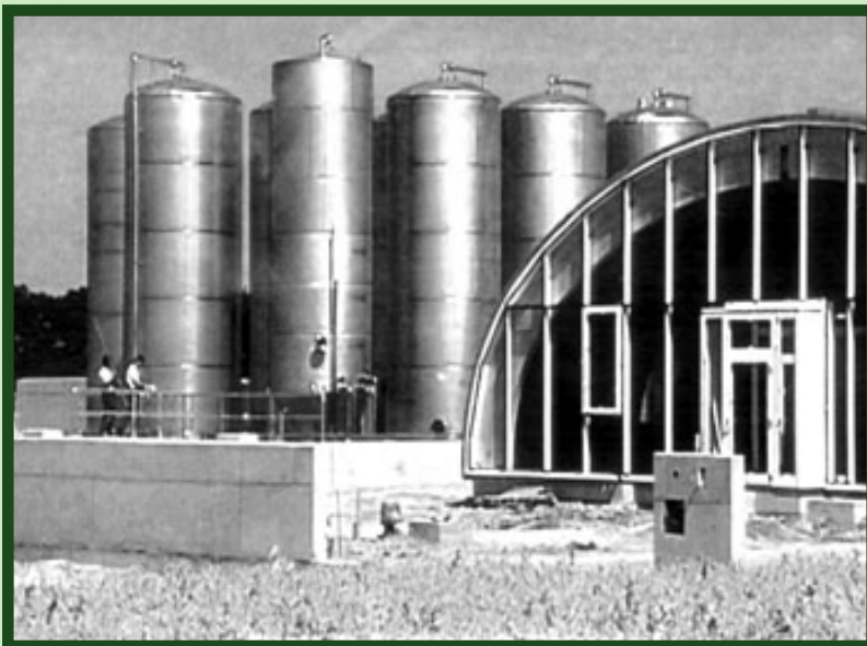
Imatge de les instal·lacions d'una planta de biodièsel ubicada a Àustria.
