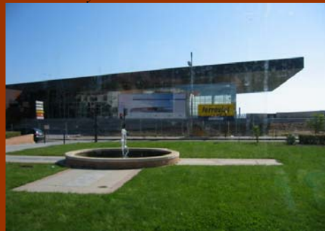
Foto 54: Centro de Recepción de Visitantes en obras.
