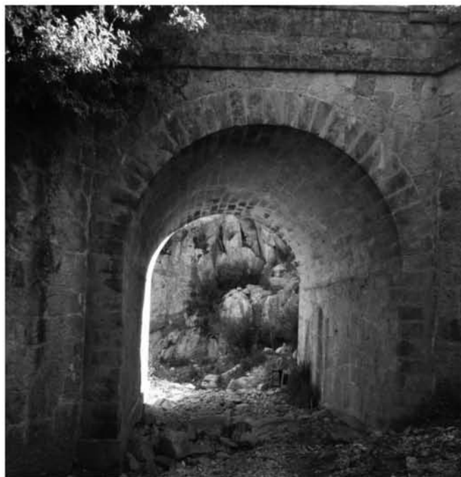
Fig. 6. Pont per salvar un petit torrent.
