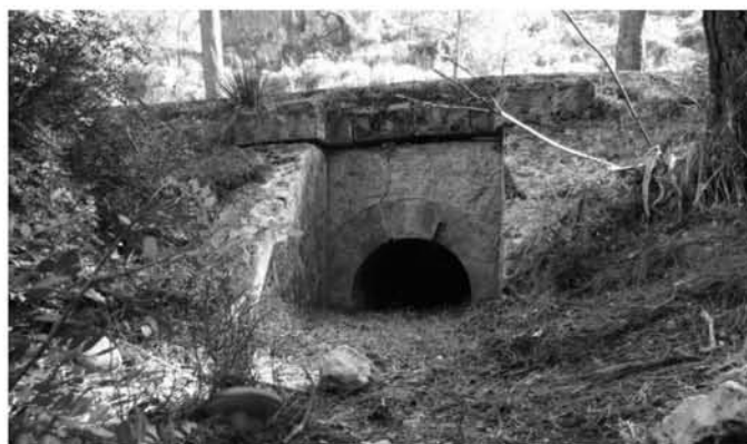
Fig. 5. Sortida d'un drenatge transversal.
