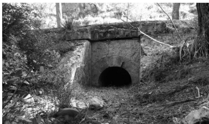
Fig. 5. Sortida d'un drenatge transversal.
