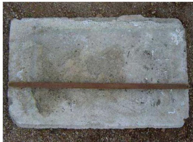
Fig. 3 Mitja cana mallorquina sobre un marès d'extracció manual
