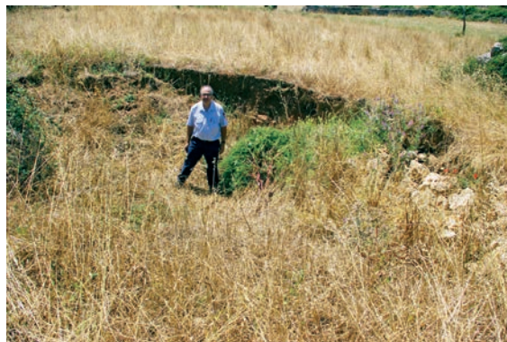
Figure 18: Imatge del col·lapse que va aparèixer l'any 2009 uns 400 metres al nord del col·lapse aparegut l'any 2005. A la imatge s'observa que aquest col·lapse provoca una depressió d'un metre en una àrea de forma circular amb un diàmetre de 5 metres.
