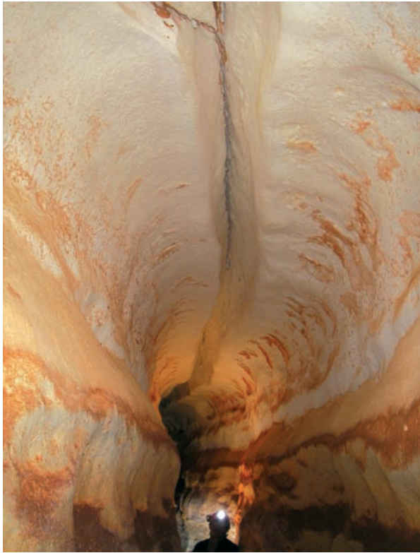
Figura 14: Canal de techo muy marcado condicionado por la existencia de una fractura. (Foto A. Merino).
