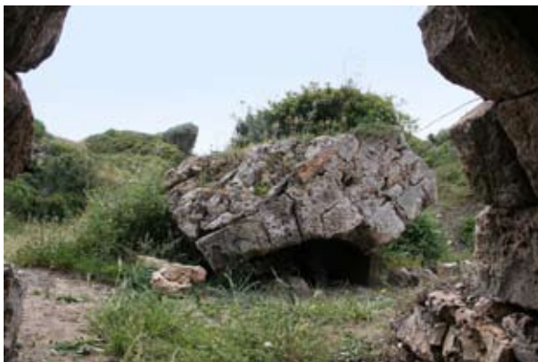
Foto 5: Galeria de Gal·les, sortida per la caponera. Al centre un bloc de la volta volada; s'hi veuen clarament les dovelles a saltacavall. Foto J. Florit.
