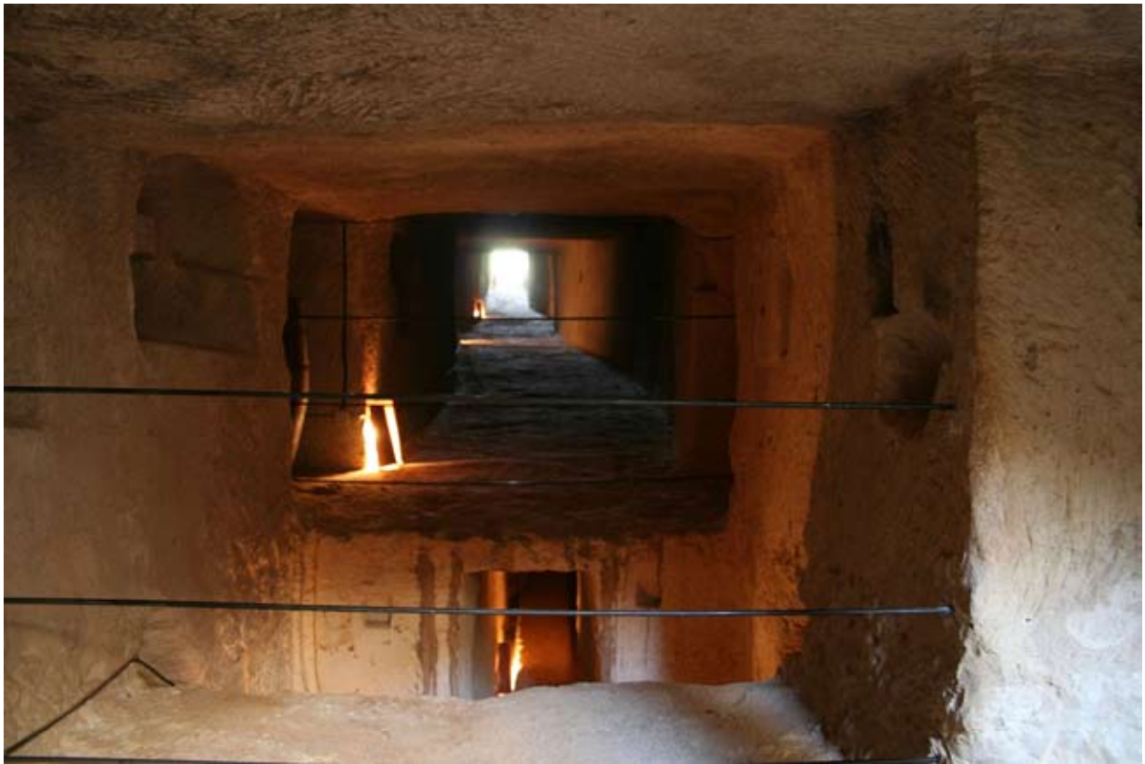
Foto 4: Galeria de Gal·les, vista axial. En primer terme el "pou de llop" amb la galeria de minat. Al fons la sortida per la caponera. Foto J. Florit.
