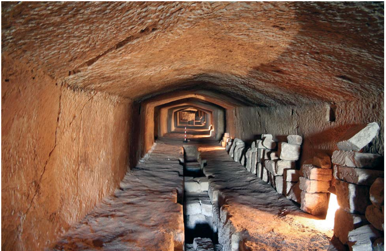
Foto 4: Perspectiva de la Gran Galeria des de l'entrada oriental, al centre del pis podem veure les galeries de minat, i a la dreta els cantons que les cobrien. Foto J. Florit.
