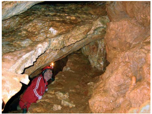
Figura 12: Un dels caminios que recorre el sector inicial de la Cova de s'Ònix, accedint per la seva entrada secundària, apareix inutilitzat per esfondraments recents del sostre.
