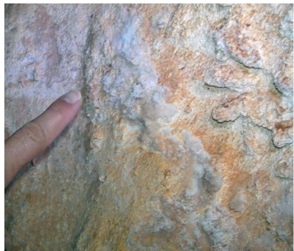
Foto 9: Aspecto de la pared de la roca donde se han desarrollado las flores de yeso. (Foto A. Merino).
