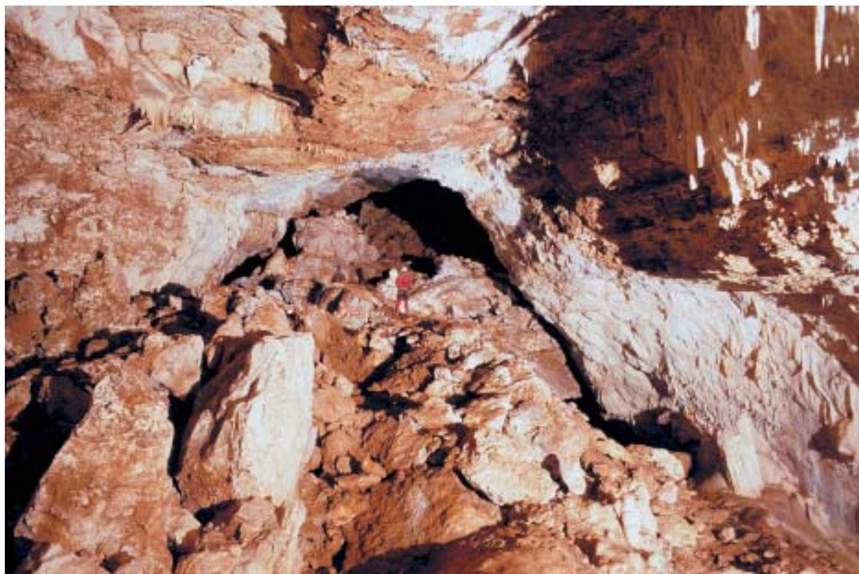
Figura 15: Morfologies d'esfondrament de la galeria Migpunt (cova des Pont). S'aprecia la tendència de la volta a adquirir el perfil d'equilibri (Foto A. Merino).
