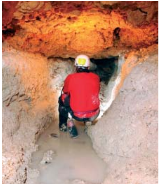
Foto 3: Tram final de la galeria de la Font de Pòrtol. Es destria clarament el junt d'estratificació entre el sostre de calcarenites i les margues on s'excava la cavitat. (Foto: G. Santandreu).
