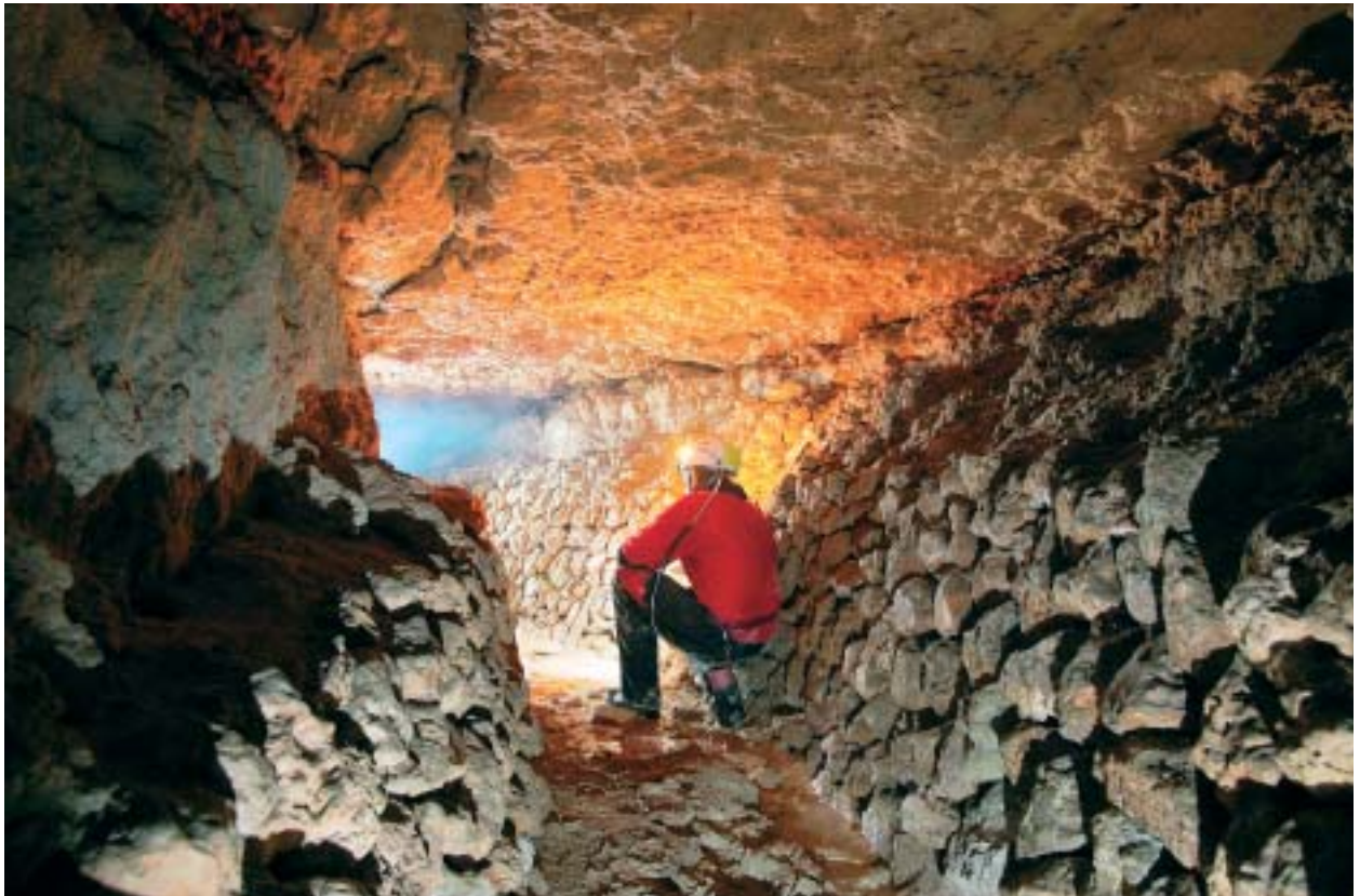
Foto 2: Font de Pòrtol, galeria excavada que porta a la surgència principal i que en els seus metres inicials transcorre amb els laterals paredats. (Foto: G. Santandreu).
