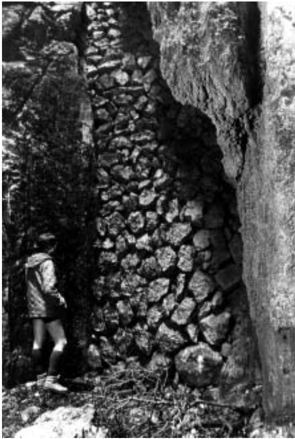
Foto 3: El gran mur interior de pedra seca del Clot de Neu Gran de sa Rateta (Bunyola), vist des del fons de l'avenc.
