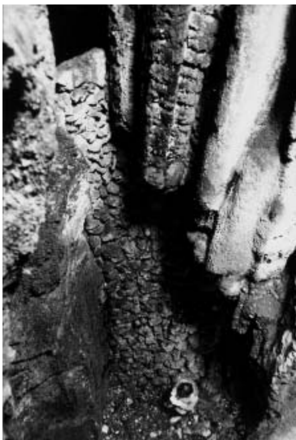
Foto 2: Fotografia presa a poc d'iniciar el descens al Clot de Neu Gran de sa Rateta (Bunyola), avenc natural que assolix una fondària de 16 metres. Al seu interior s'hi localitza un gran mur de pedra seca, de 7 metres d'alçada, construït per tal de condicionar la cavitat per a les tasques d'emmagatzematge de neu.
