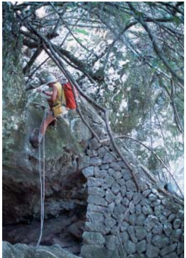
Foto 4: Rapelant el S 4 vora l'arc on es recolza la canaleta que surt de la font de s'Espinal. Foto: G. Santandreu.
