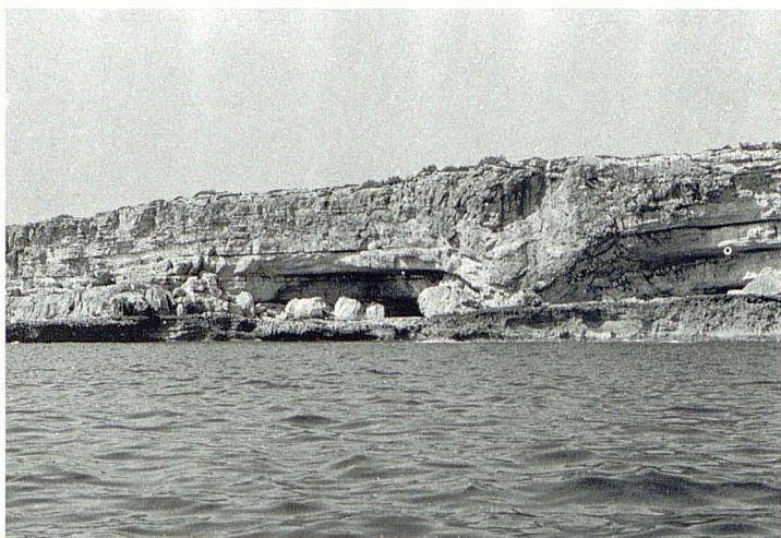
Foto 1: Col·lapse càrstic originat a les calcàries recifals, que ha acabat deformant els nivells de la seqüència superior.
