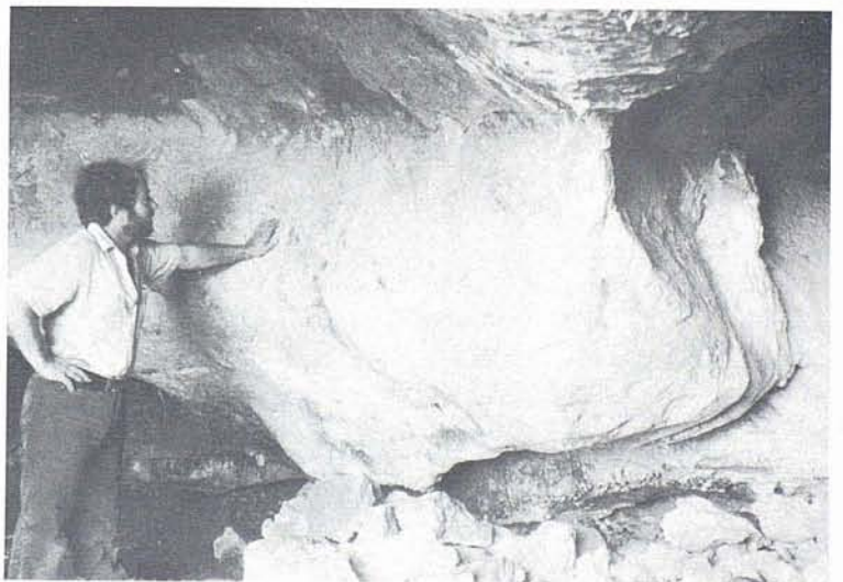
Foto 4: Gran regata a la sala d'entrada. S'aprecia un embà de roca tallat en excavar-se la regata en els seus dos costats.
