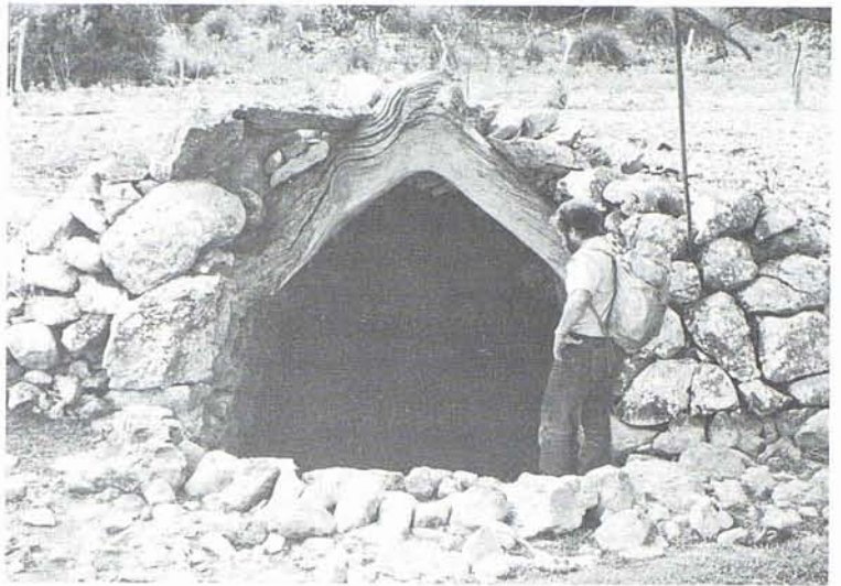
Foto 1: Depòsit (bassa) cobert per arreplegar aigua de pluja en el poljé de Ses Basses; en segon terme se n'aprecia la superfície plana.
