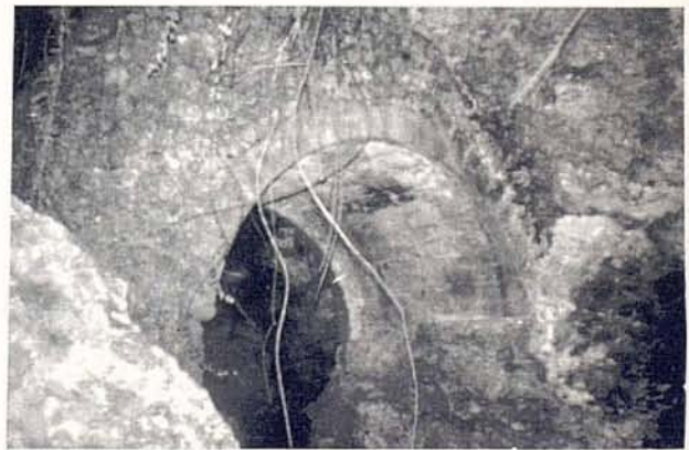
Pont d'accès a la cova homònima
