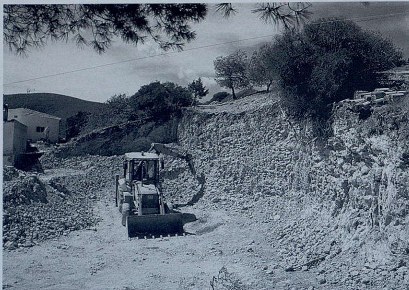
El Pla Estrella ideat per l'exministre de Medi Ambient Jaume Matas també ha duit la destrucció del territori a Cabrera. A la imatge, una màquina es menja part de la muntanya de darrere el port per fer-hi un edifici nou.
