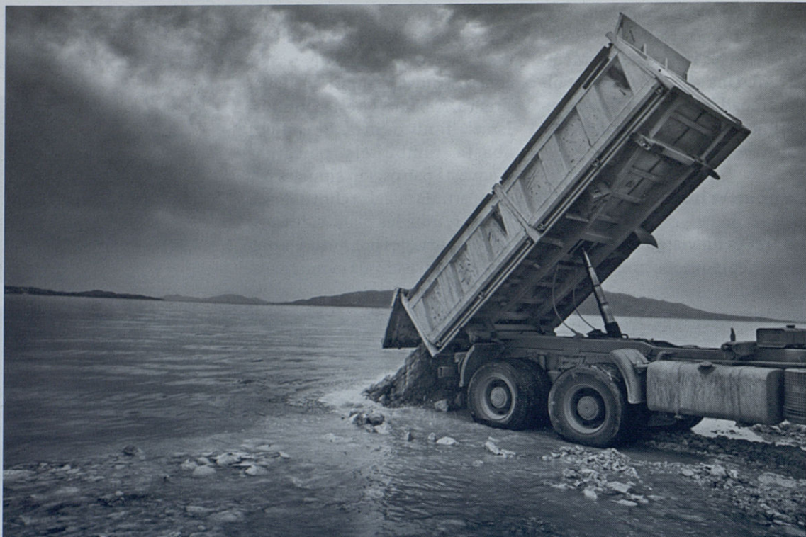
Construcció d'apartaments. Saranda, Albània.
