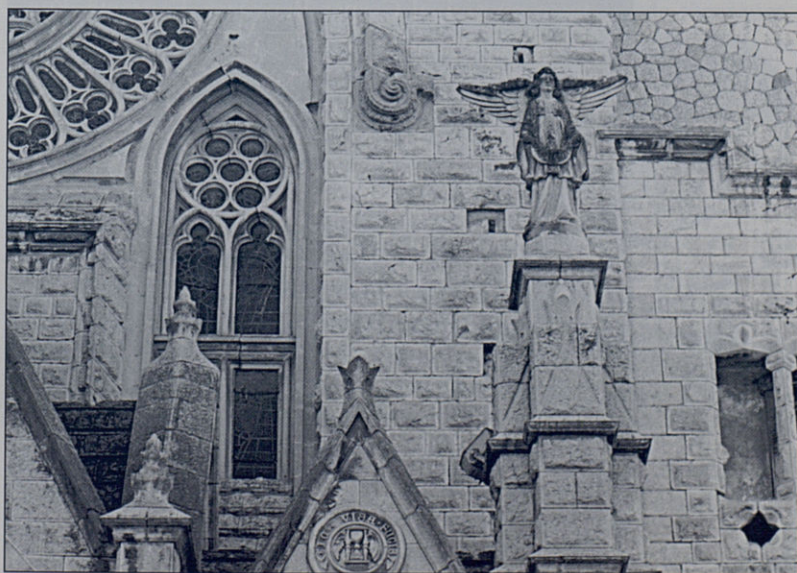
Aspecte de la façana de l'església de Sòller.
