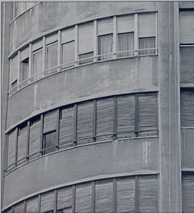
Edifici del carrer de Llorenç Vicens, 3. Palma.
