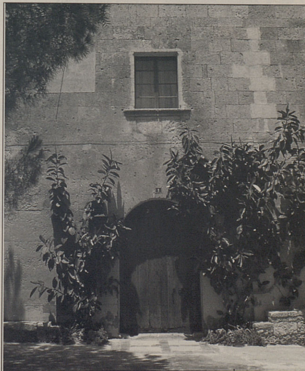
Vista de la façana exterior de la casa de s'Heretat, que es troba a Son Servera.
