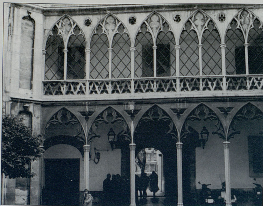
Galeria neogòtica a l'Hospital General de Palma. D'entre els establiments hospitalaris que des del segle XIII administraven les parròquies, els de Sant Andreu, Santa Catalina i del Sant Espirit es fusionaren el 1456 per crear l'Hospital General. (Foto J.M.B.)
