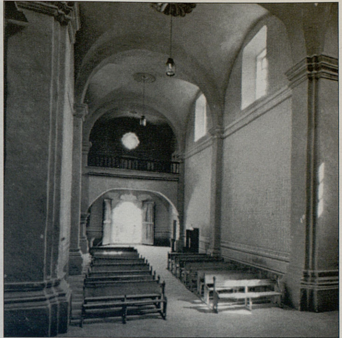
Interior de la missió de Conca, la més estranya de les cinc missions mexicanes de Serra, potser a causa d'un mestissatge més prounciat. Els murs laterals tenen arcs de descàrrega reforçats amb contraforts.
