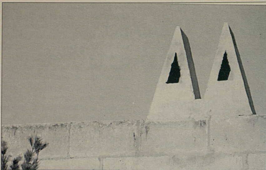
L'estructura d'aquesta construcció és vista, no hi ha res amagat o emmascarat.
