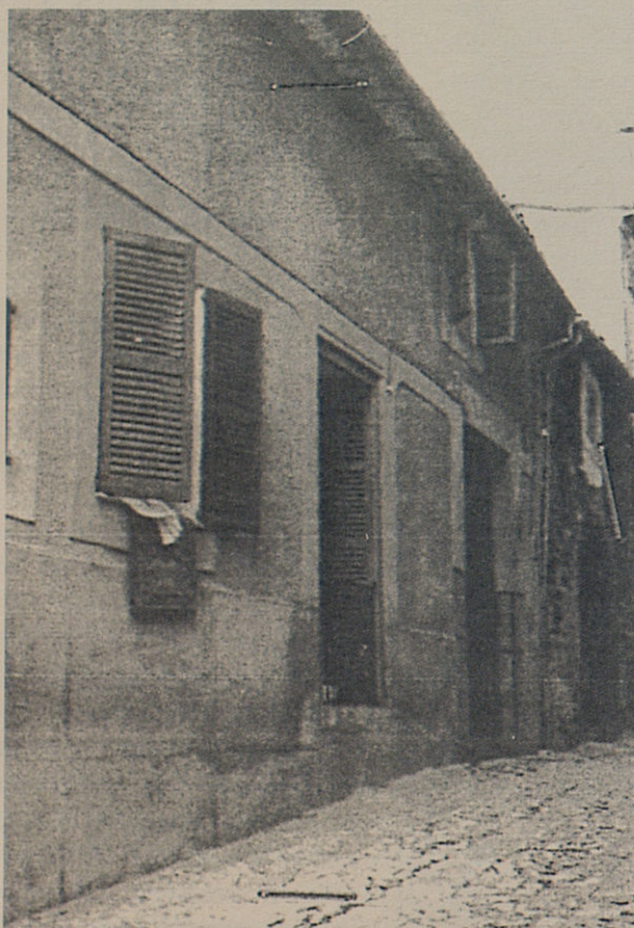
FAÇANA ABANS DE LA RESTAURACIÓ
