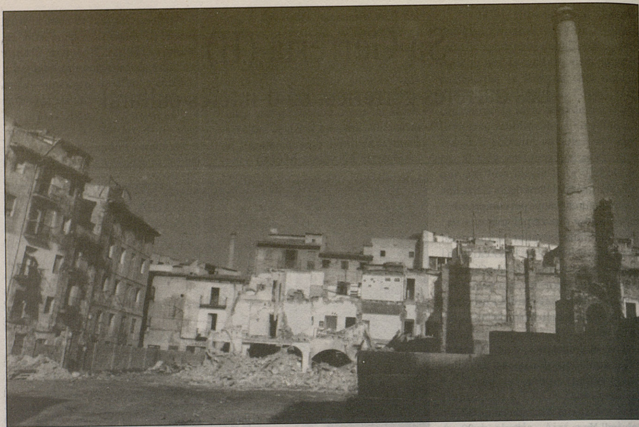
Procés d'enderrocament de la illeta dels carrers del Socors, Gerreria, Vila i Ballester al gener de 1990. A cop d'ull s'hi veien vestigis d'arquitectura gòtica als espais més o manco arrasats. (Foto: J. Llabrés)
