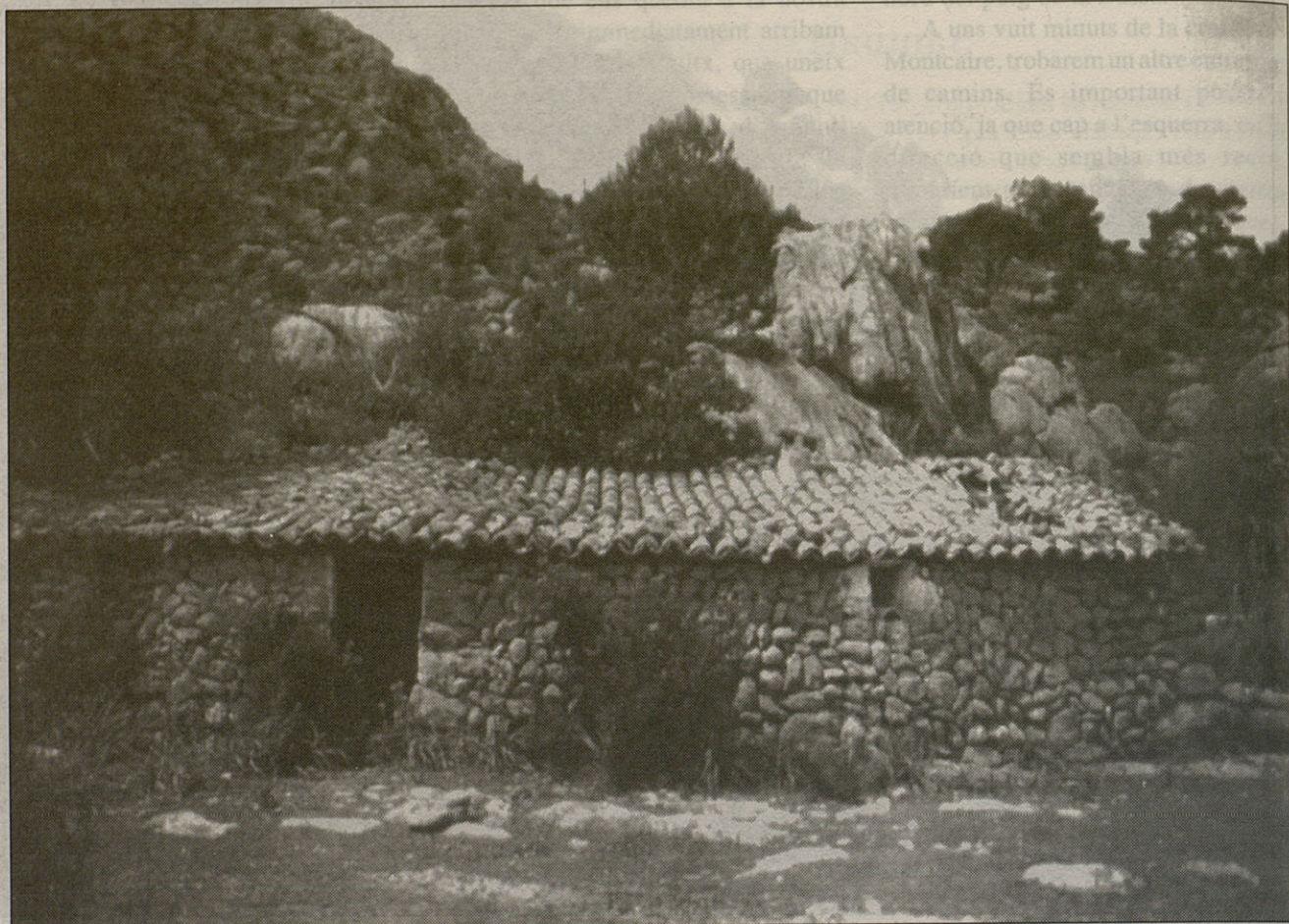
La rústica construcció de la Tanca dels Bous.
