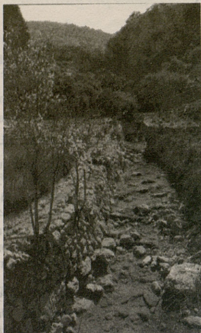
Conducción de aguas del torrente de Almellutx, en Mallorca.
