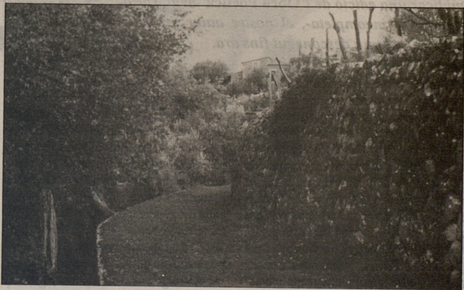
Entre Can Prohom i l'Heretat trobam la major part de les actuacions de restauració de l'Escola de Margers. Val la pena observar en detall el resultat d'aquests treballs.
