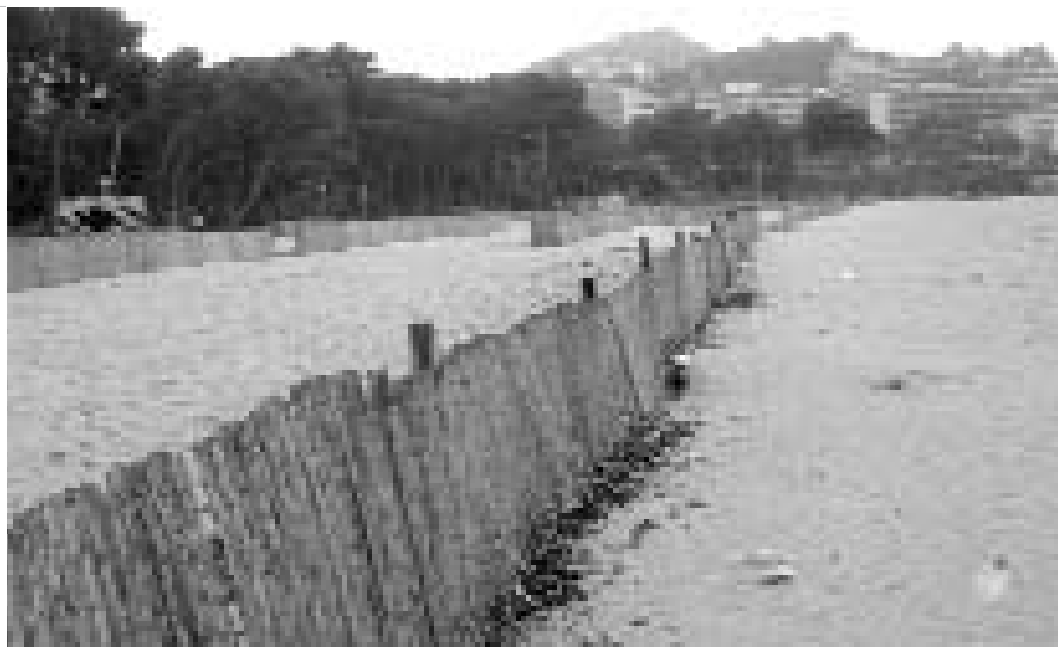
6.8: Cañizos captadores de arena en una playa
