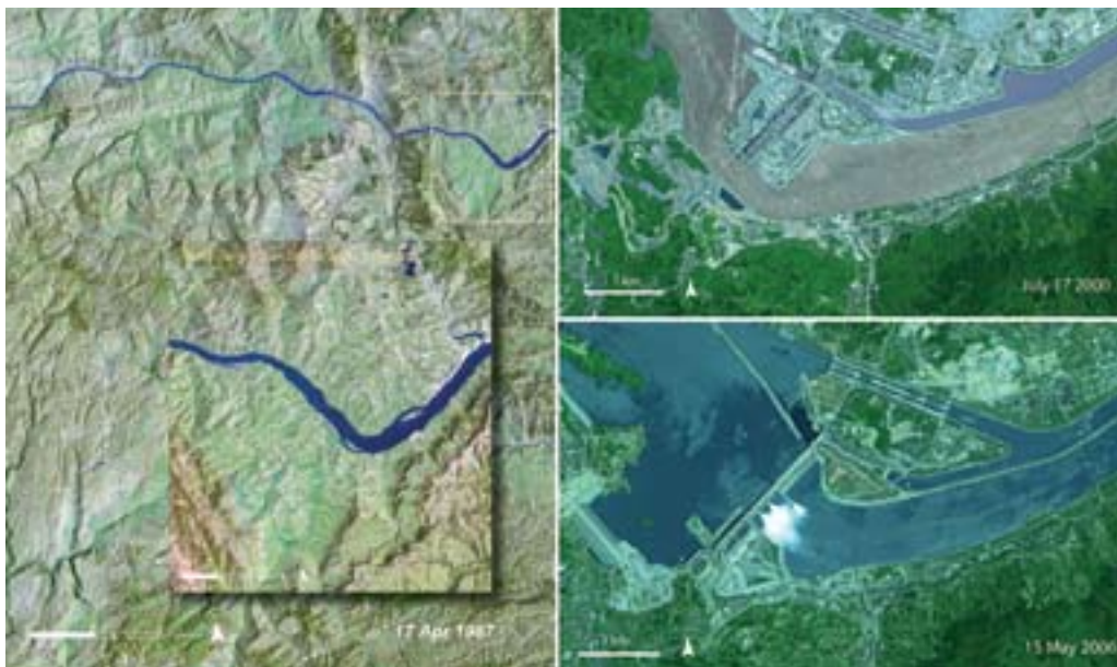
La presa de las Tres Gargantas en China: la imagen de 1987 de la izquierda muestra el río y el paisaje que lo rodea (visión general y detalle) antes de que se construyera la presa; la imagen de 2000 (parte superior derecha) muestra la presa en construcción y en la imagen de 2006 (parte inferior derecha), la presa está en funcionamiento.
