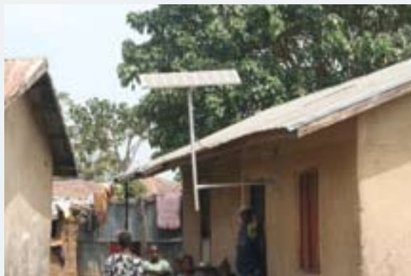
En Nigeria, un panel solar provee iluminación interior como parte de un proyecto piloto auspiciado por el PNUD para aumentar la utilización de energía solar.
