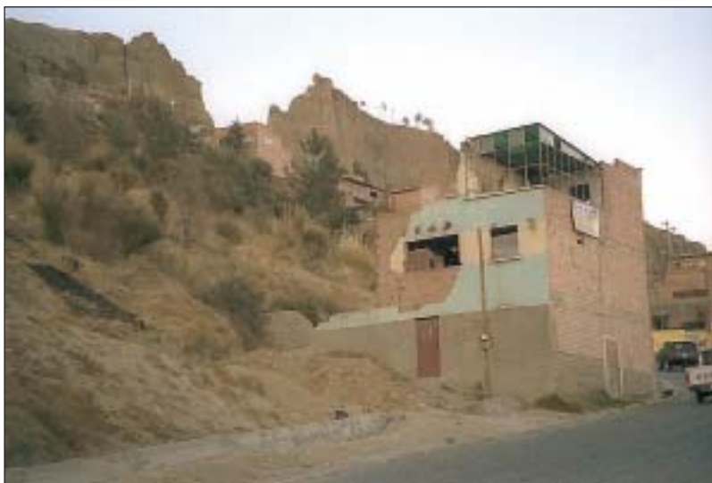
Restos de una vivienda “sobreviviente” del desprendimiento de tierras del cerro Cotahuma. Foto 1: CEPLAG
