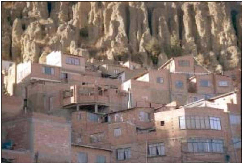
Viviendas “recostadas” en la serranía de Cotahuma, en peligro permanente por la inestabilidad del suelo. Foto 4: CEPLAG
